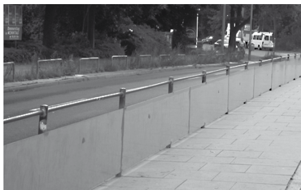
Ein Erfolg der Luruper Verkehrs-AG: Der Spritzschutz am schmalen Wartebereich an der Haltestelle Trabrennbahn. Foto: AG Verkehr
