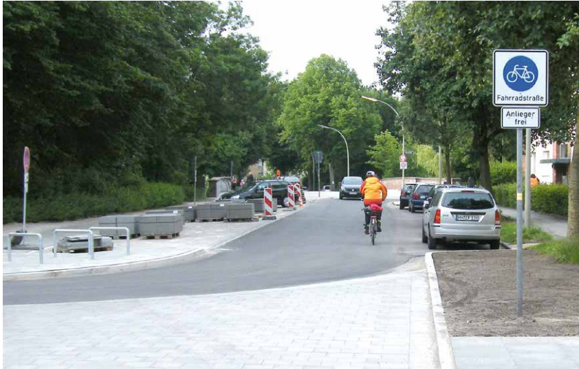
Fahrradstraße Uferstraße kurz nach der Fertigstellung
