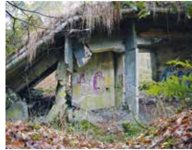
Wegen der Betontrümmer heißen die Besenhorster Sandberge im Volksmund Bunkerwald.
