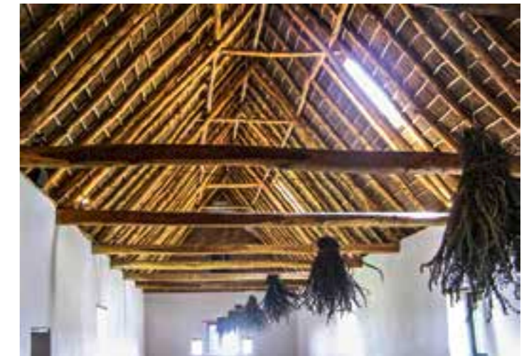
Die Innenansicht auf ein reetgedecktes Dach in Südafrika, bei dem jeder einzelne Halm sichtbar bleibt.
