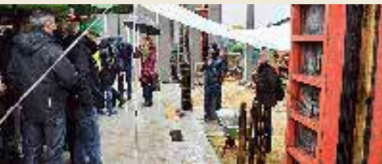
30 Beim Grundstein helfen alle Handwerkerhof Ottensen nimmt Gestalt an
