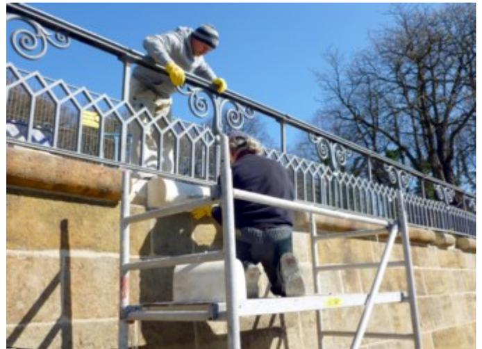
Mitarbeiter der Firma Schmalstieg bei der Erneuerung der Wulstplatte mer und Meißel werden parallele Rillen in den Sandstein eingehauen. Diese Technik erfordert sehr sorgfältiges Arbeiten. Die Firmen ▶
