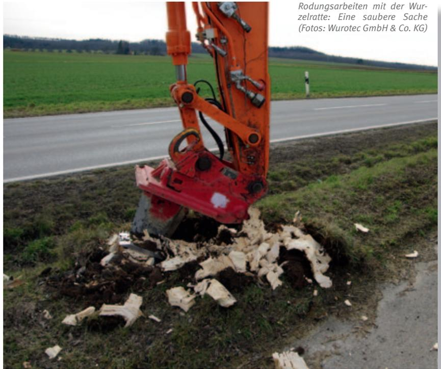
Rodungsarbeiten mit der Wurzelratte: Eine saubere Sache (Fotos: Wurotec GmbH & Co. KG)
