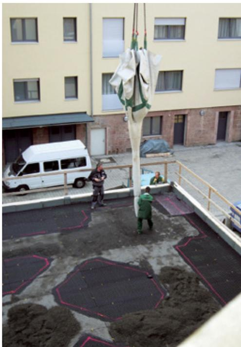
Der lange Auslass des Turbobags ermöglicht eine gute Verteilung des Schüttguts. (Fotos: ZinCo GmbH)
