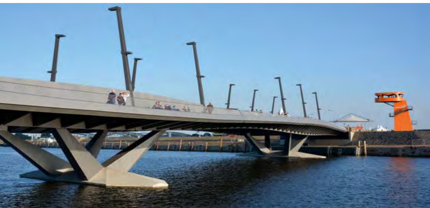
Le nouveau pont de Baakenhafenbrücke n'est pas seulement la principale voie de liaison au sein du quartier : cette élégante construction en acier relie directement la zone sud à la station Hafencity Universität de la ligne U4
