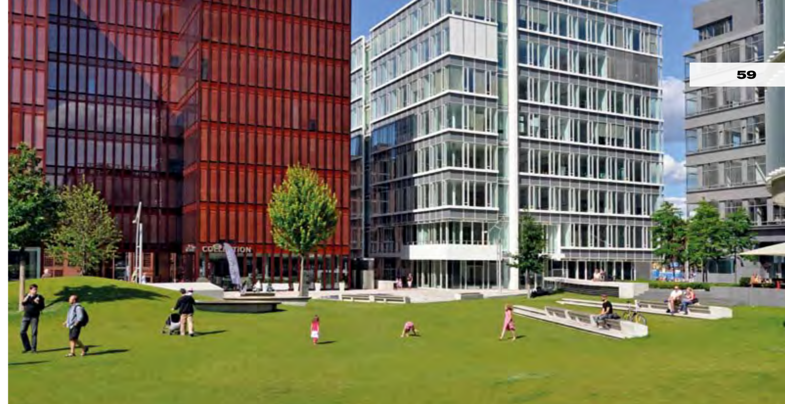
Les espaces publics de la Hafencity (ici, le parc de Sandtorpark), sont réalisés avec de grandes exigences en termes de qualité
