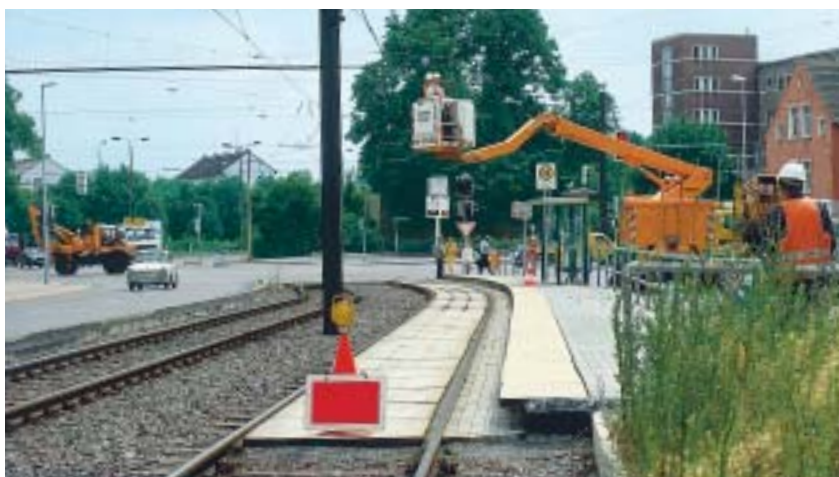
Gut sichtbar im Gleis aufgestellte Haltscheiben sind bei Arbeitsstellen im Gleisbereich von Straßenbahnen geeignete Technische Einrichtungen.
