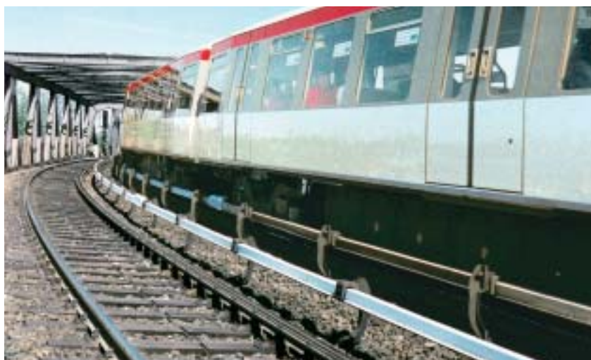
Bei Unterweisungen muss auf die besonderen Gefahren an der jeweiligen Arbeitsstelle hingewiesen werden. Durch Bauwerke und Streckenführung kann z. B. die Sicht auf Züge im Gegengleis beeinträchtigt sein.
