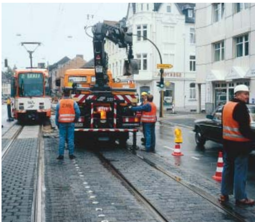
Bei Arbeiten im Verkehrsraum öffentlicher Straßen ist es von besonderer Wichtigkeit, dass Personen, die mit Sicherungsaufgaben betraut sind, für ihre Tätigkeit einen Standort außerhalb der Fahrspuren für den Individualverkehr finden.
