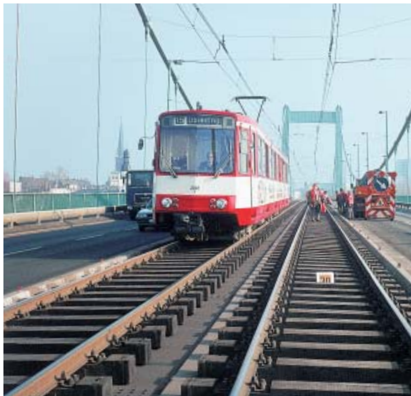
Wenn der Sicherheitsraum im Bereich einer Fahrbahn für den Individualverkehr liegt, ist anzustreben, dass für den sicheren Aufenthalt von Personen sowie für die erforderliche Lagerung von Material ein Teil der Fahrbahn in Anspruch genommen werden kann. Ist dies nicht möglich, muss das Gegengleis vorübergehend gesperrt werden können. Die erforderlichen Sicherungsmaßnahmen sind dann in einer Bau- und Betriebsanweisung (BETRA) festzulegen.
