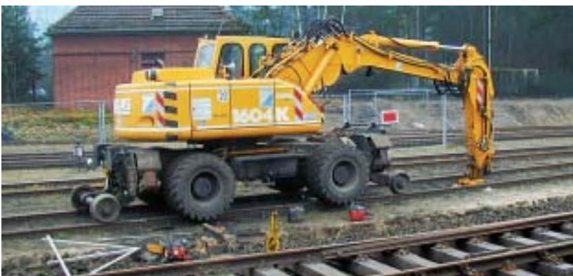
Fahrten von gleisfahrbaren Baumaschinen in Arbeitsstellung bis zu 5 km/h sind nach den Bestimmungen der Unfallverhütungsvorschrift »Bauarbeiten« (BGV C 22) zu sichern.
