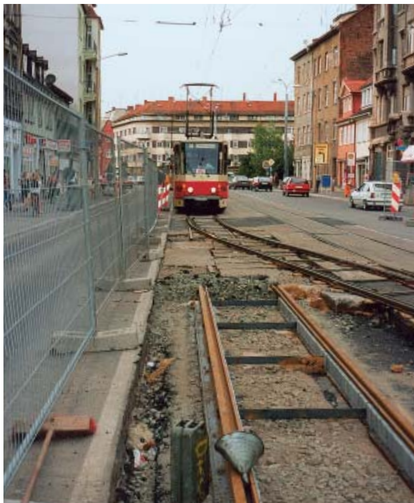
Durch geeignete Absperrungen können Arbeitsstellen gegenüber den Gefahren aus dem Straßenverkehr oder aus Nachbargleisen effektiv gesichert werden. Deren Aufstellung muss in der Sicherungsanweisung geregelt sein.
