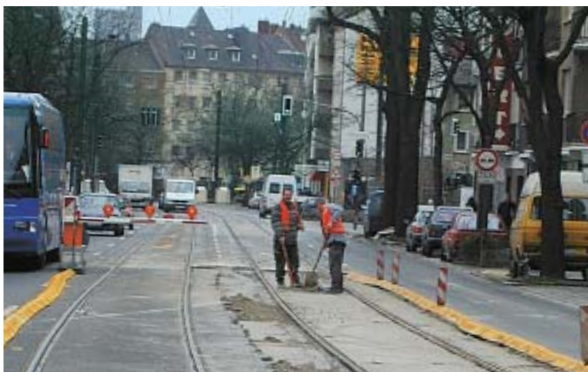
Wenn Arbeitsstellen beidseitig durch Technische Einrichtungen, wie z.B. Absperrschranken, gegen das Befahren von Schienenfahrzeugen gesichert sind, sind weitere Sicherungsmaßnahmen gegenüber Fahrten im Nachbargleis nicht erforderlich. Absperrschranken verhindern auch zuverlässig das Eindringen des Individualverkehrs in die Arbeitsstelle.
