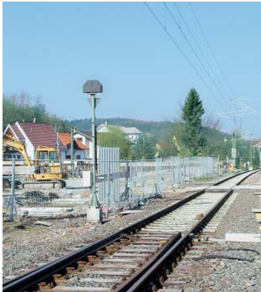
Wenn Arbeitsstellen ohne Kranbetrieb neben Gleisen eingezäunt sind, kann auf weitere Sicherungsmaßnahmen verzichtet werden. Der Zaun darf nur mit Zustimmung der für den Bahnbetrieb zuständigen Stelle errichtet werden.
