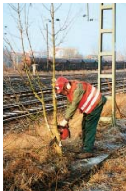
Bei Vegetationspflegearbeiten sind auch dann Sicherungsmaßnahmen erforderlich, wenn diese außerhalb des Gleisbereiches durchgeführt werden, weil die Gefahr besteht, dass Fall- oder Schnittgut in den Gleisbereich geraten kann.
