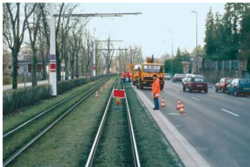
Absicherung einer Arbeitsstelle im Gleisbereich einer Straßenbahn mit Haltscheibe (Signal Sh 2 nach BOStrab). Für Materiallagerung und Aufenthalt von Personen ist eine Fahrspur gesperrt.
