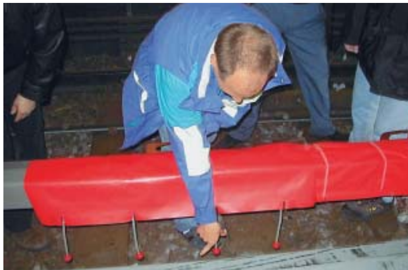
Für Arbeiten in unmittelbarer Nähe der Stromschiene hat ein Unternehmen eine überfahrbare Stromschienenabdeckung entwickelt. Die mögliche Länge des Arbeitsbereiches ist durch den Abstand der Stromabnehmer an den Fahrzeugen bestimmt.
