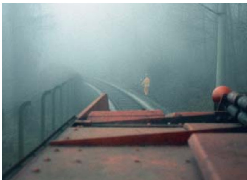
Bei schlechten Sichtbedingungen müssen die Arbeiten unverzüglich eingestellt werden, wenn nicht durch technische Hilfsmittel das Herannahen von Zügen rechtzeitig erkannt wird.
