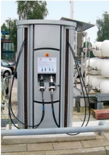
Diese Wasserstoff-Tankstelle für Pkw und Busse ist mit einem zentral angebrachten NOT-AUS-Schalter ausgerüstet.
