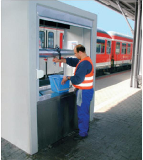
Medienentnahmestellen sollen in Abständen von max. 50 m aufgestellt werden, um die Tragearbeiten zu minimieren.
