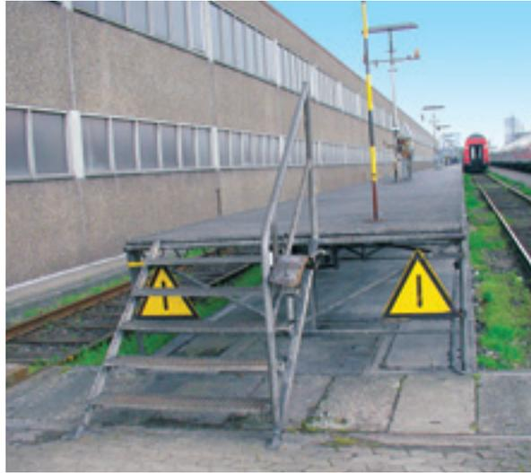
Wenn die Treppen oder Rampen nicht so breit wie die Arbeitsbühne sind, müssen die stirnseitigen Absturzkanten neben der Treppe oder Rampe mit Geländern ausgerüstet werden. Diese Geländer dürfen den seitlichen Sicherheitsabstand von 0,5 m nicht einschränken. Das bedeutet, dass diese Geländer in der Regel einen Abstand von 2,2 m zur Gleismitte haben müssen.
