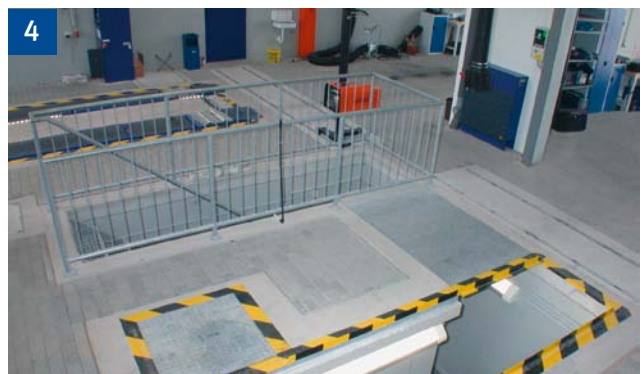
4 Zugang zur Grube Prüfgrube mit seitlichem Eingang
