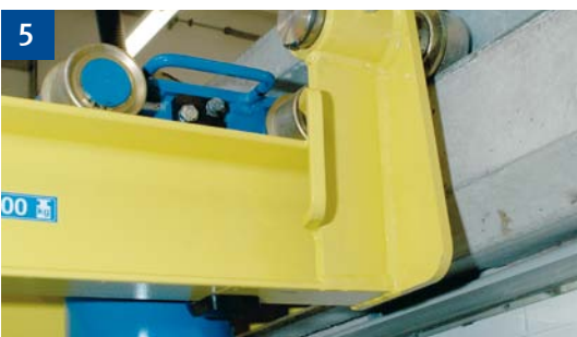
Sicherung des Grubenhebers gegen Kippen in Quer- und Längsrichtung
