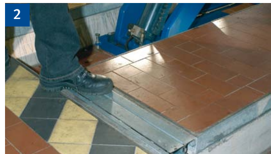
Sicherung der Stolperstelle
