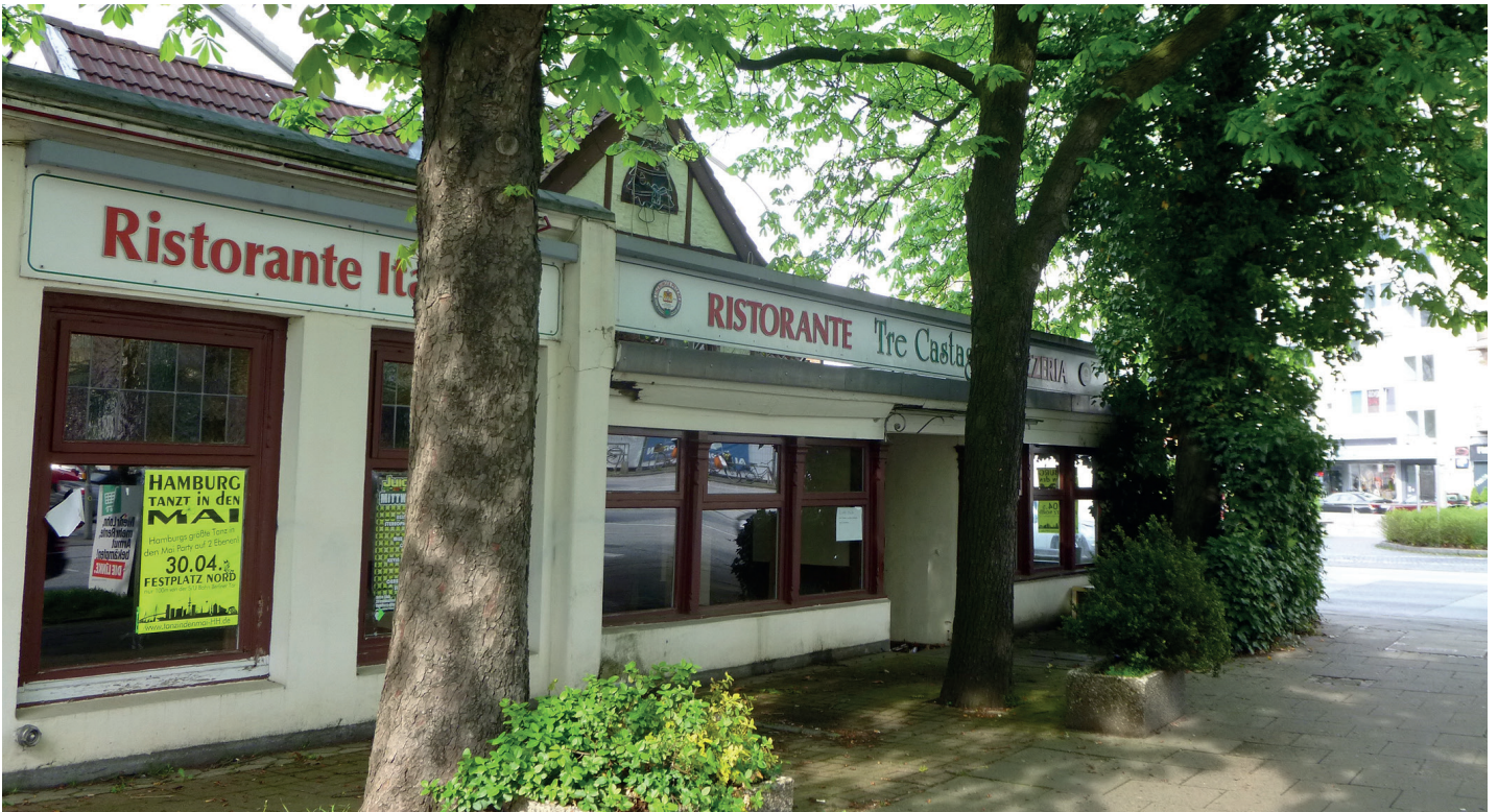
Prägt den Charakter des Eppendorfer Marktes seit 1779: Das alte Fachwerkhaus, das zuletzt das Restaurant „Tre Castagne“ beherbergte
