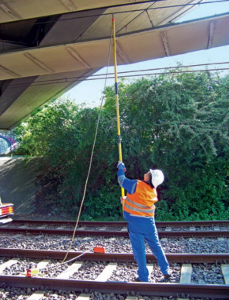
Aufgrund des häufig straßenbündigen Gleiskörpers wird bei Straßenbahnen das Erden (vierte Sicherheitsregel) mittels Gleismagneten eingesetzt.
