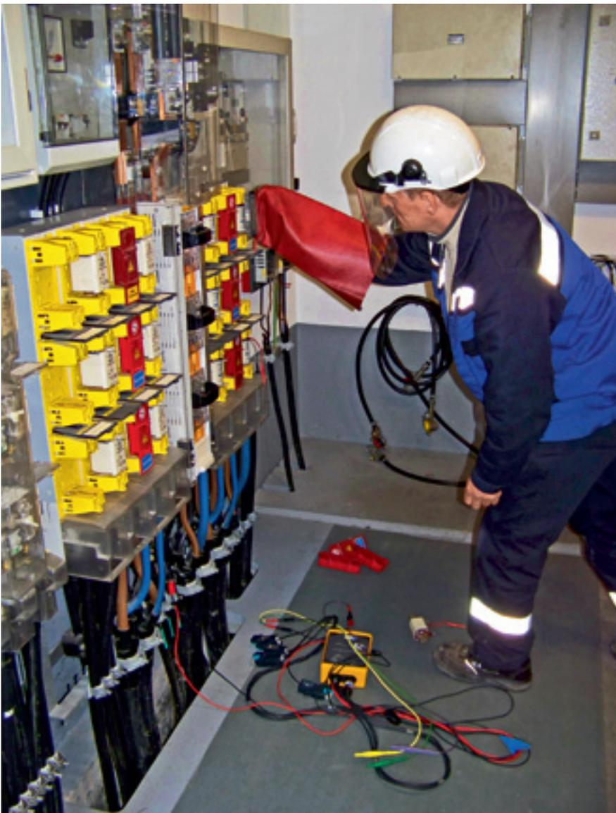
Elektrofachkräfte können die elektrischen Gefährdungen, zum Beispiel Entstehung von Störlichtbögen beim Ziehen von NH-Sicherungen, selbstständig erkennen und beurteilen.
