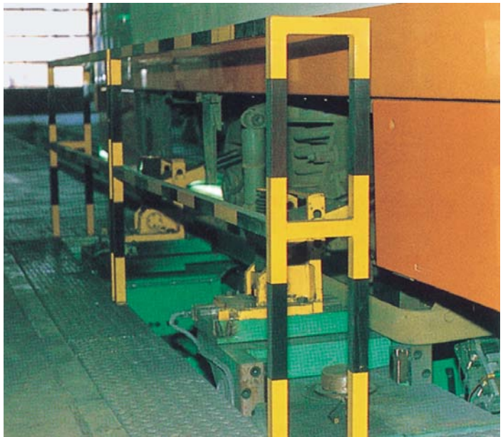
Abbildung 10: Zur Vermeidung der Absturzgefahr ist das Geländer unmittelbar am Fahrbereich angebracht.
