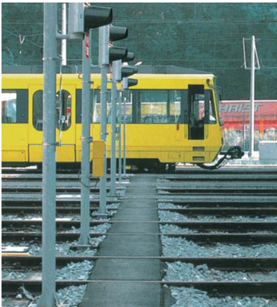
Abbildung 18: Zum Queren der Gleise ist vor der Abstellhalle ein ausreichend breiter Verkehrsweg in Höhe der Schienenoberkante angelegt.
