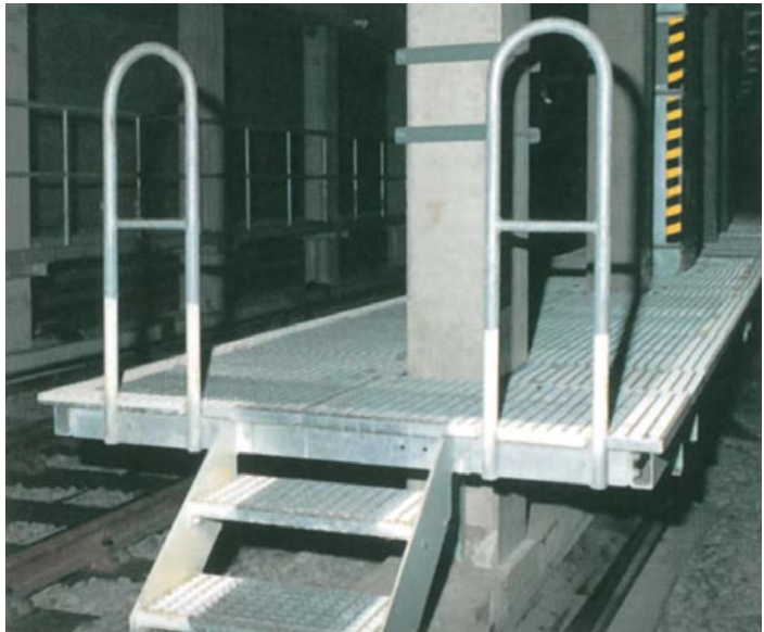
Abbildung 16: Die Treppe ist erheblich schmaler als der Laufsteg. Mit den Schutz- bügeln wird der Absturzgefahr vorgebeugt.
