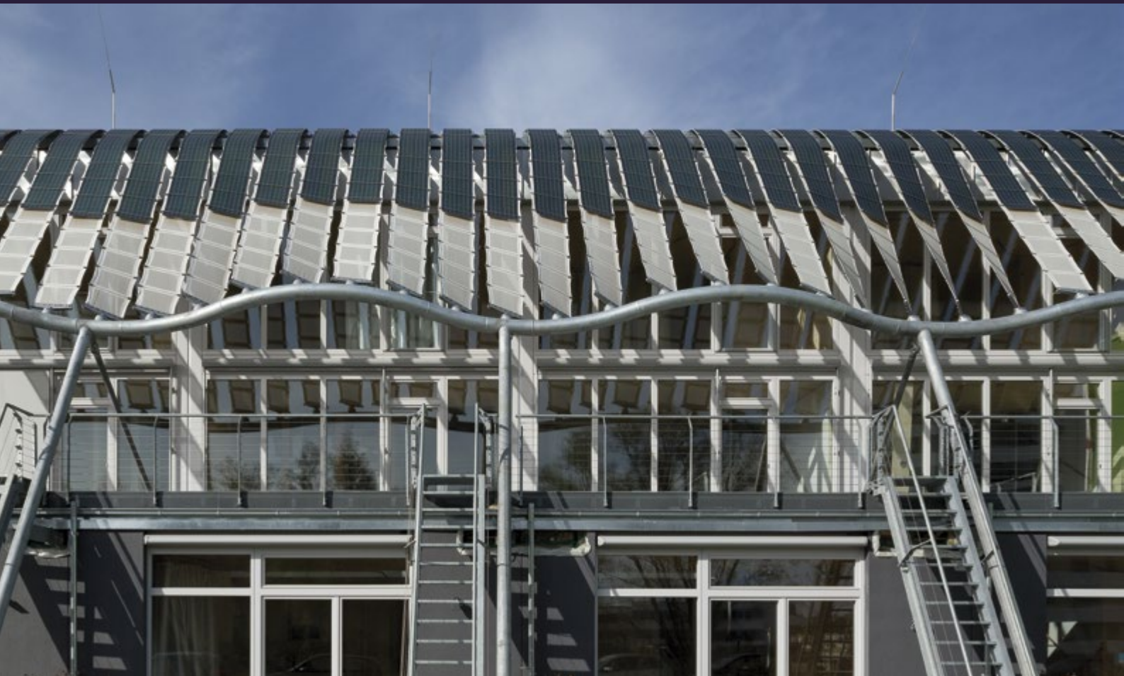
Die Membranfassade des Soft House reguliert den Lichteinfall und fängt mit Solarzellen zusätzliche Energie ein. Foto: IBA Hamburg GmbH/Bernadette Grimmstein.
