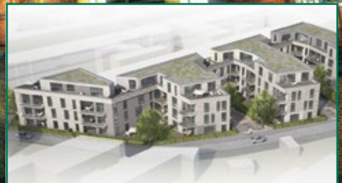
49 Eigentumswohnungen Elbhöfe Ottensen
