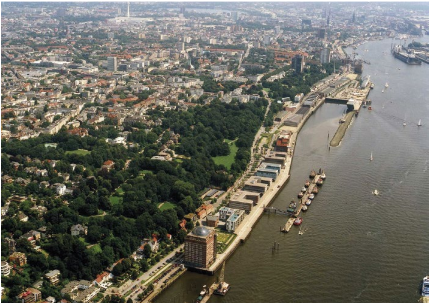
Der rote Backsteinbau des Augustinums schließt die Elbmeile stromabwärts ab.
