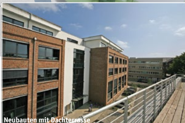
Neubauten mit Dachterrasse
