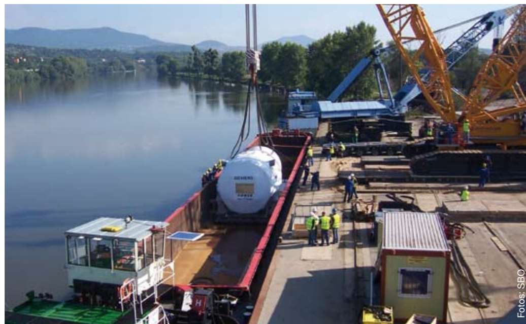
Ein Siemens-Aggregat wird im Hafen von Lovosice auf ein Binnenschiff gehoben
