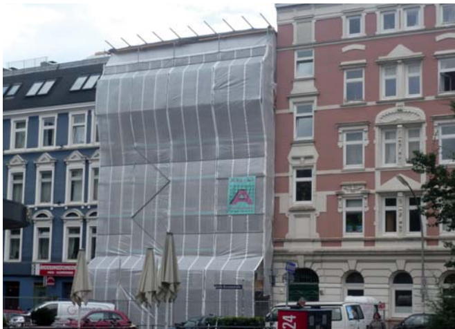
Altbauten: Auch mit einer reduzierten Mieterhöhung für viele nicht mehr erschwinglich.
