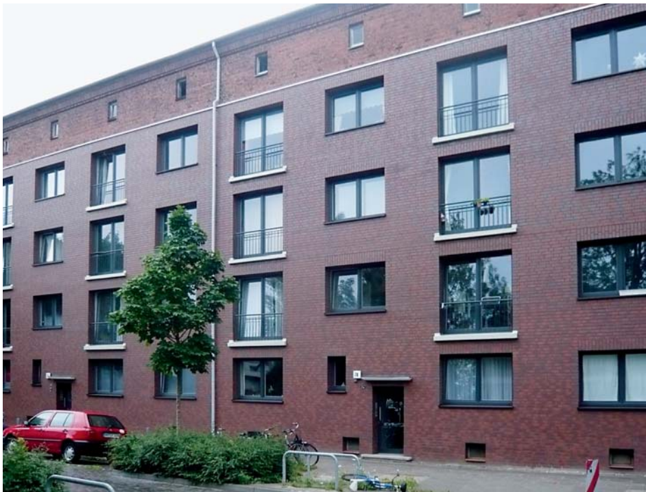
Wärmedämmung: Energiekosten gesenkt, Mieten explodiert
