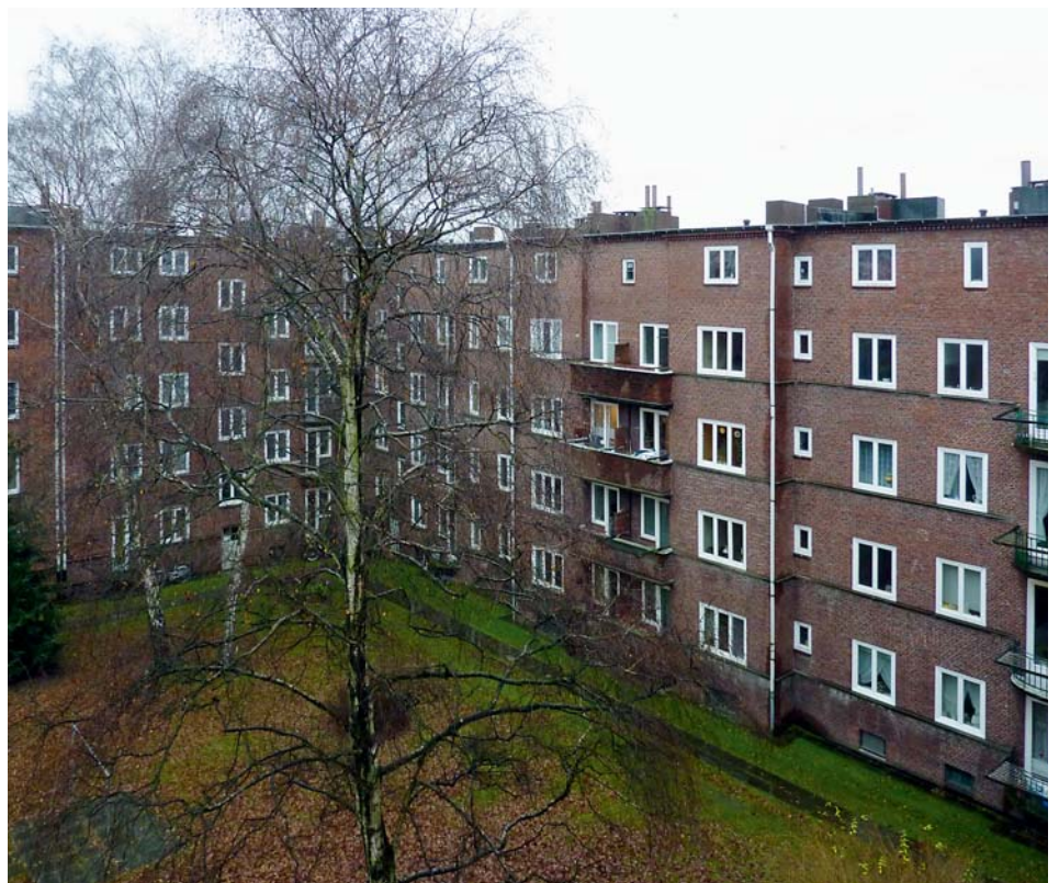
Mit einer Wärmedämmung auf der Innenhofseite wären die Bewohner einverstanden.
