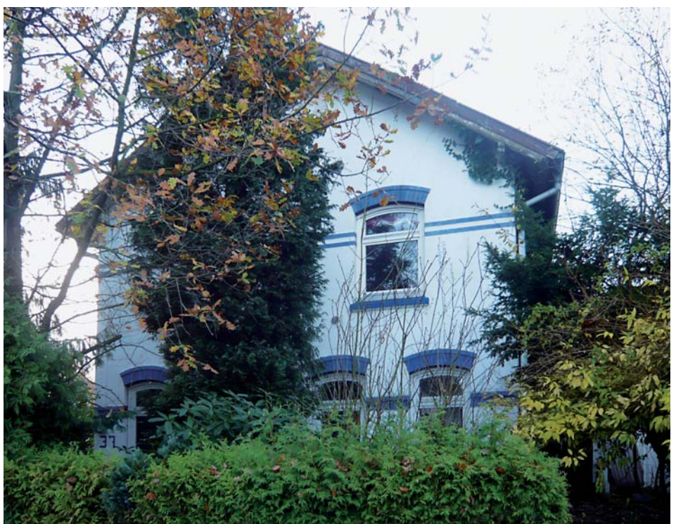
Osdorfer Landstraße 37: Einfach abgerissen
