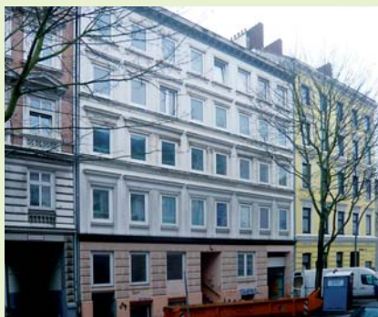
Mieter einverstanden: Bald wird saniert.
