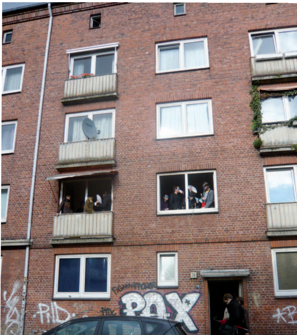
Noch im letzten Jahr wurde in diesen Häusern in der Bartelsstraße eine Fette-Mieten-Party gefeiert – wegen zu teurer Neuvermietungspreise.
