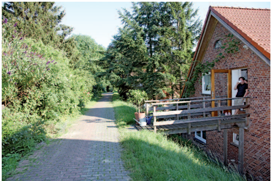
Zufriedene Mieter in saniertem SAGA-Haus mit Zugang zum Elbdeich und eigenem Garten
