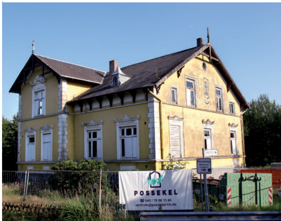
Und hier haben die Handwerker noch einiges zu erledigen: unsanierte SAGA-Villa mit den Spuren jahrzehntelanger Vernachlässigung.
