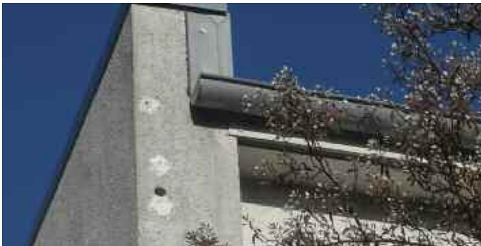
Der natürliche Feind einer intakten Wärmedämmung ist der Specht. Hier ein Beispiel für die Vergeblichkeit menschlichen Tuns und die Uneinsichtigkeit des Tieres. Loch 4 ist noch offen.
