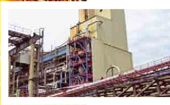
Anlage. Die BLG-Technologie erhöht den Wirkungsgrad bei der Kohlevergasung.
