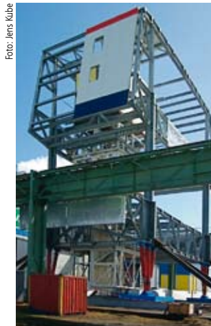
TEST. Probeaufbau der „Neumayer III“ in Bremerhaven.
