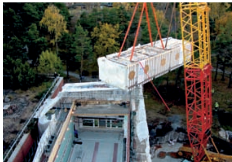
Einbringung der Druckkammer in den eigens konzipierten Neubau.
