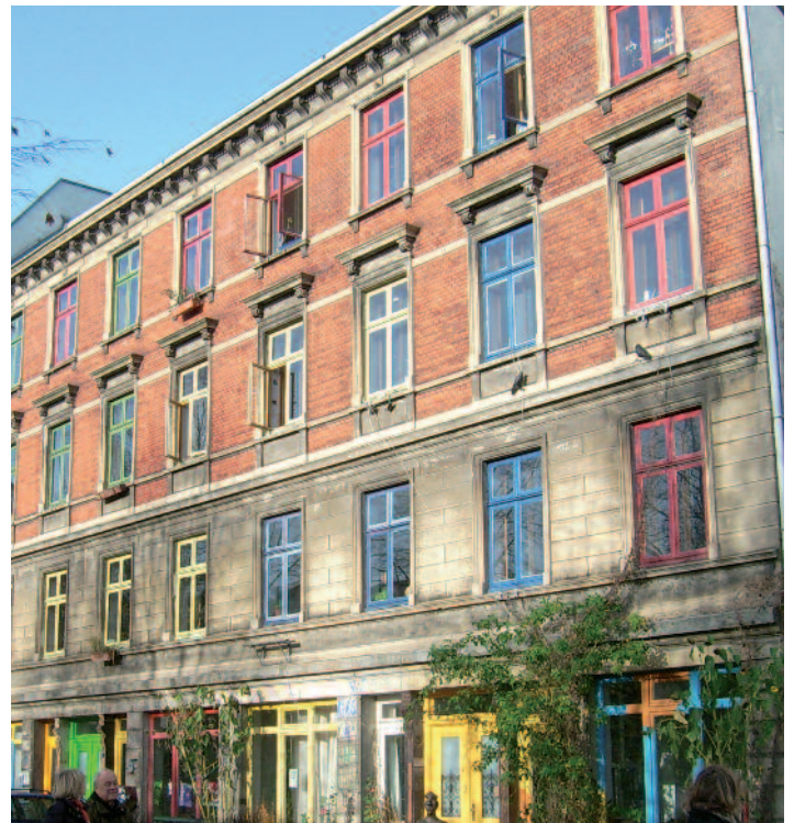
Chemnitzstraße 3-7, Selbsthilfe Altona e.V., 7 Wohnungen, z.T. Wohngemeinschaften 742 qm, Fertigstellung 1988.
