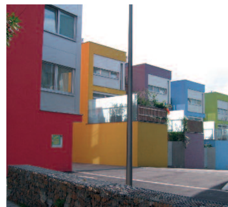
Städtebauliches Großprojekt auf einem ehemaligen Fabrikgelände im Süden Wiens (12. Bezirk) mit einem vielfältigen Mix aus Alt und Neubauwohnungen (ca. 900 geförderte Wohneinheiten), Geschäften, Lokalen, Büros und kulturellen Einrichtungen, durchmischt mit Grün- und Erholungsraum. Das Konzept wurde im Rahmen eines Bürgerbeteiligungsverfahrens erarbeitet. Errichtet: 2004-2008. Eigentümer: Kabelwerk Bauträger GmbH (Ein Zusammenschluss gewerblicher und gemeinnütziger Bauträger).
