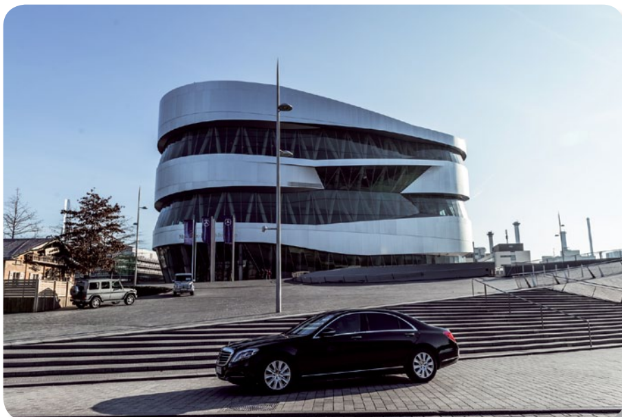
Nachhaltiges Bauen war auch beim Bau der Pflasterflächen beim Mercedes-Benz-Museum Stuttgart ein wichtiges Kriterium. Hier wurden die Fugen (16'000 qm Pflasterfläche) mit dem dauerelastischen, versickerungsfähigen Öko-Mineral-Fugensand verfüllt. (Foto: NATURAFIX)
