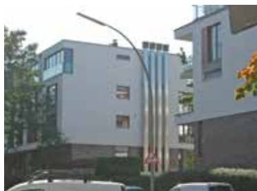
Wohnbebauung des 21. Jahrhunderts
