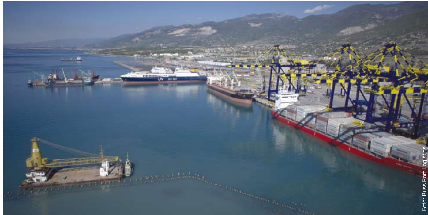
In Iskenderun hat der Baukonzern Limak ein Containerterminal für Großschiffe errichtet
