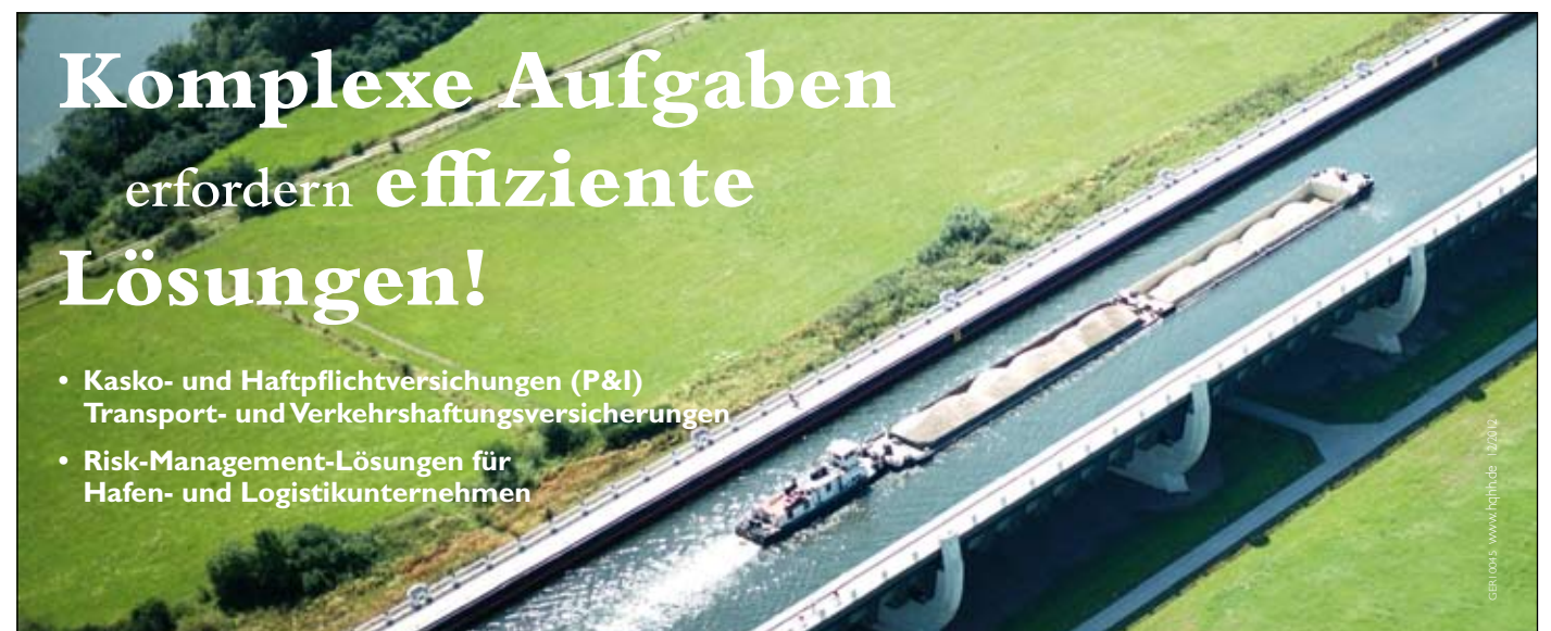
Trogbrücke über die Elbe bei Rothensee am Wasserstraßenkreuz Magdeburg
