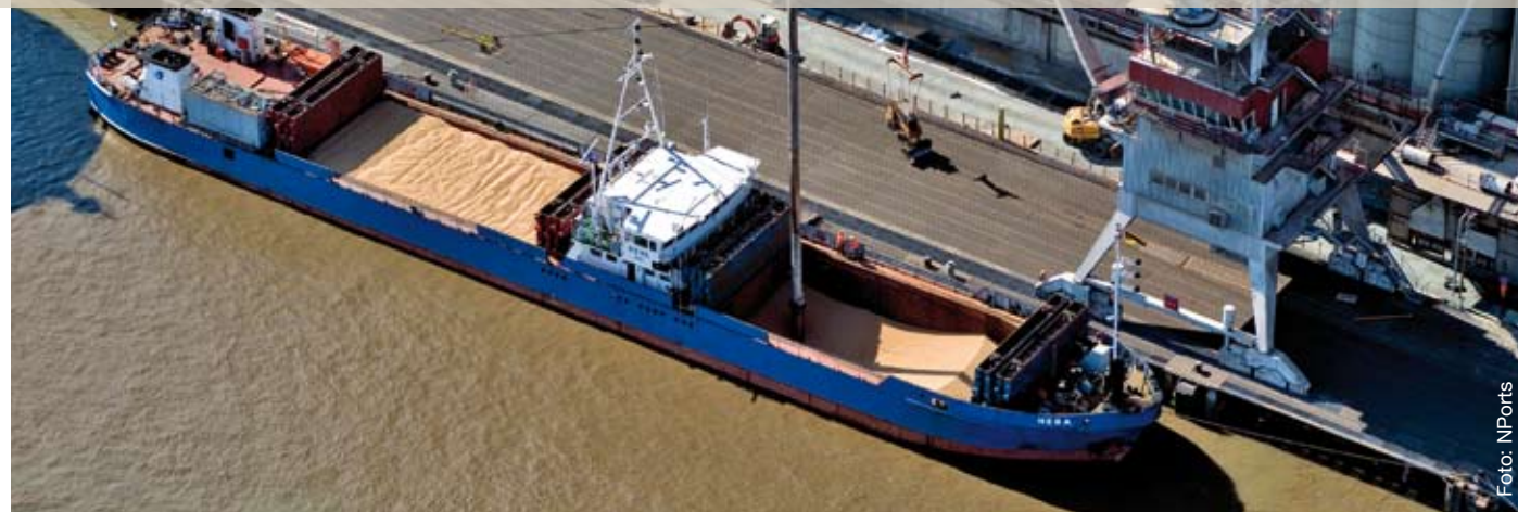
In Brake soll ein zweiter Liegeplatz für Großschiffe für den Getreideumschlag entstehen
