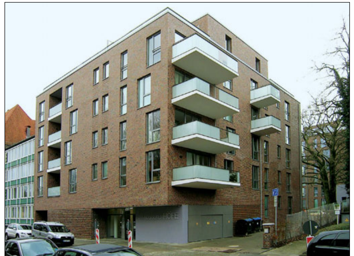
Das Vorderhaus des Ensembles Wandsbeker Höfe in der Schädlerstr. 24.
