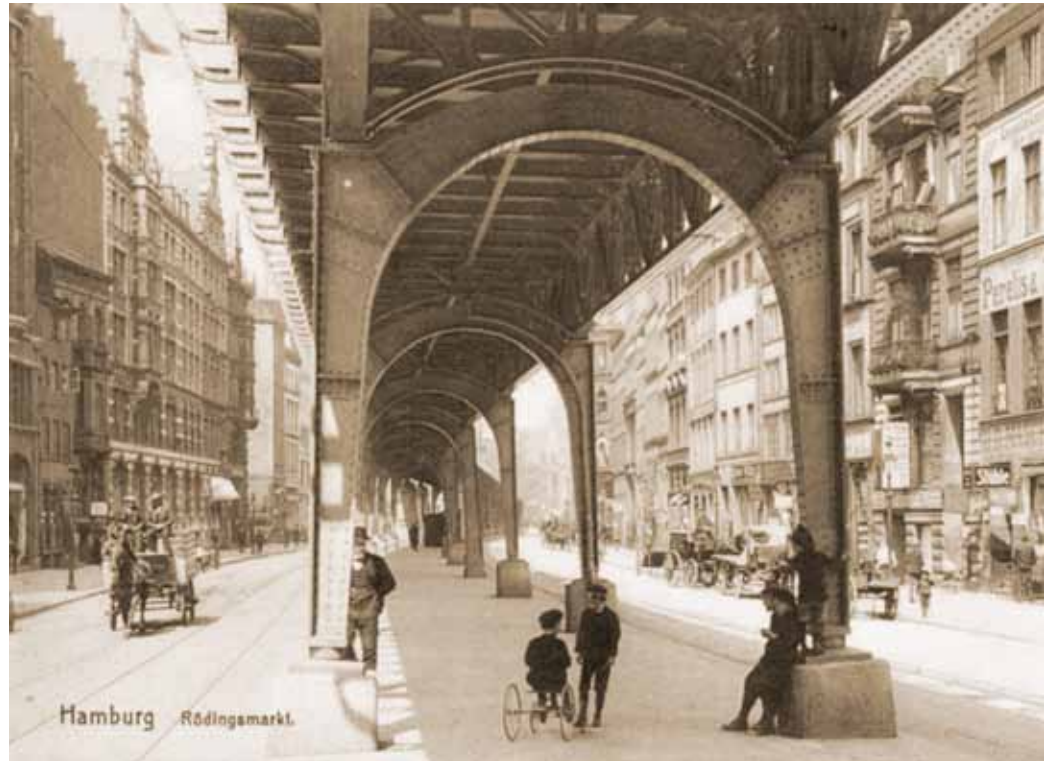
Die ersten Metro-Strecken werden auf Stelzen gebaut, um den Straßenraum nicht in Anspruch nehmen zu müssen, Rödingsmarkt 1912
