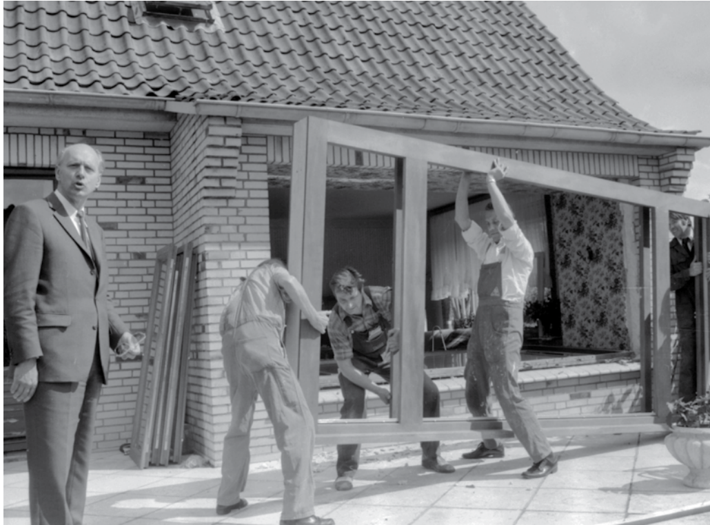
Einbau von Lärmschutzfenstern, 1974
