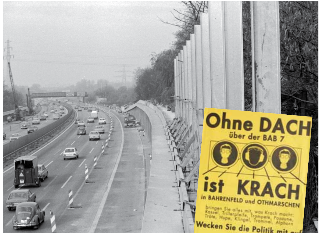
Bau der Lärmschutzwand an der Autobahn bei Stellingen, 1976
