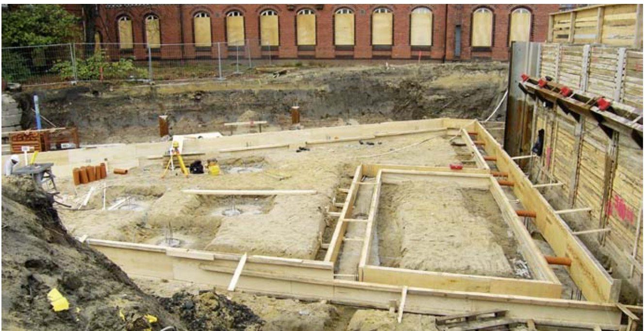
Einbau der horizontalen Flächendrainage und der Fundamentdurchbrüche
