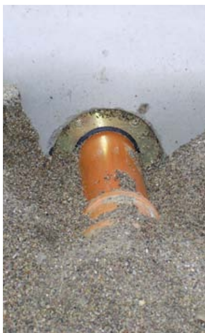
Gasdichte Leitungsdurchführung
