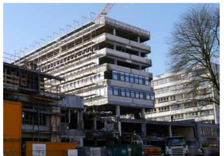
und die Modernisierung des Bestandsgebäudes Schillerstraße 44 wurde der zweigeschossige Sockel an der Neuen Großen Bergstraße abgebrochen. Ziel ist die Beseitigung der bisherigen Rücksprünge in der Fassade und der Neubau einer neuen, einheitlichen Fassadengestaltung im Bereich der zukünftigen Laden- und Gastronomieflächen.
