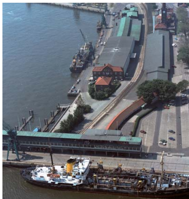
Wasserschutzpolizeirevier 4, Lentzkai, Cuxhaven
