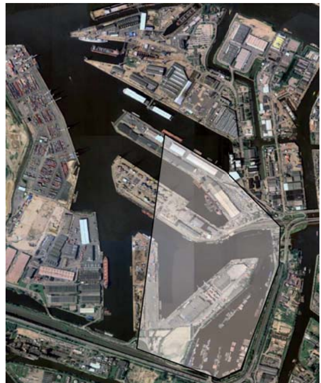
Neubau des Container-Terminals Steinwerder
