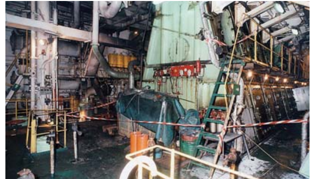
Maschinenraum der „Enalios Eliki“ nach der Explosion
