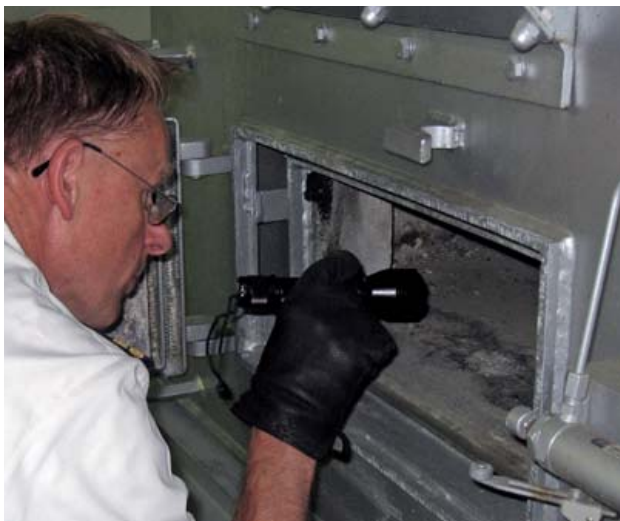
Kontrolle einer Müllverbrennungsanlage auf einem Schiff
