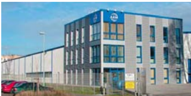
ZENTRALE. Vom Firmensitz in Dessau aus beliefert AEM Kunden in aller Welt mit hochwertigen Drehstrom-Asynchronmotoren und Drehstrom-Synchrongeneratoren.
