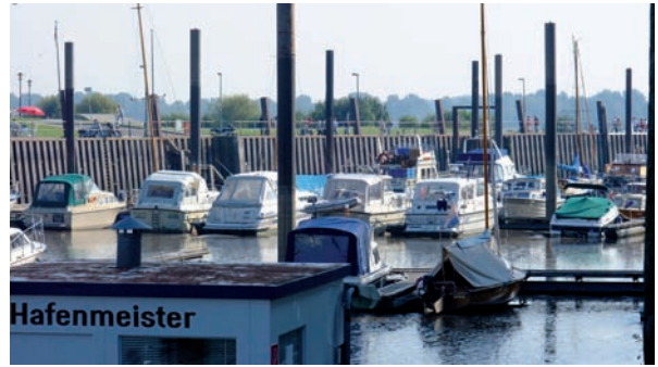
Wedels Hafen wird runderneuert
