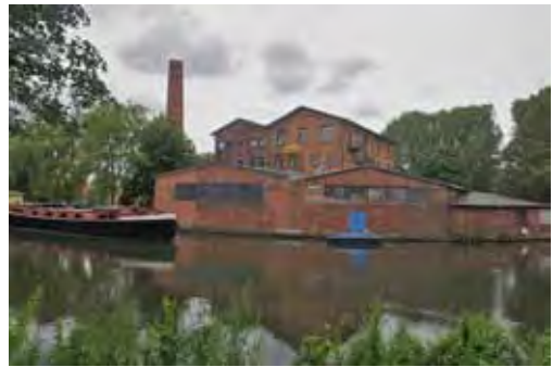
Abb. 44: Sicht vom Veringkanal auf das Fabrikgebäude
