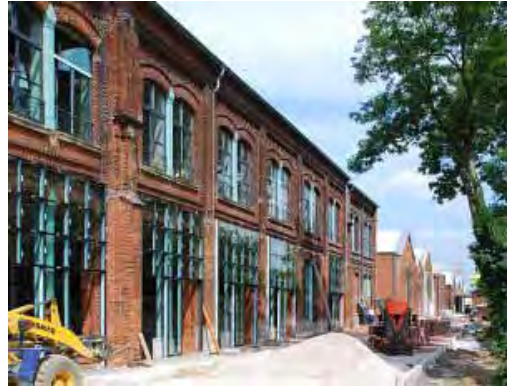
Abb. 53: Sanierung und Restaurierung der Hallen des Ausbesserungswerkes ab 2006
