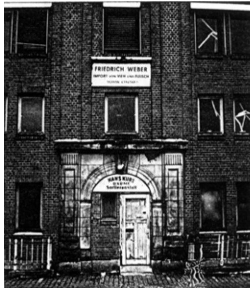
Abb. 92: Bestandsfoto der Fassade des Kopfbaus von 1990 mit alten Firmenschildern
