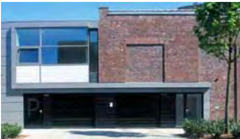
Abb. 50: Verbindung von alter und neuer Substanz am Beispiel der Halle E
