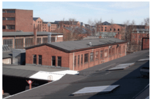
Abb. 51: Blick auf eine der backsteinernen ehemaligen Produktionshallen
