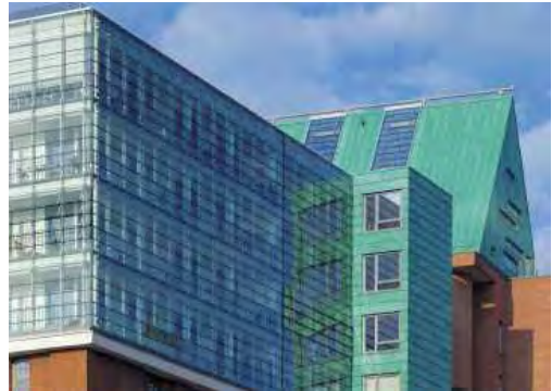
Abb. 42: Blick auf die die Aufstockung mit Wohnnutzung und das erneuerte Kupferdach des Silo-Gebäudes
