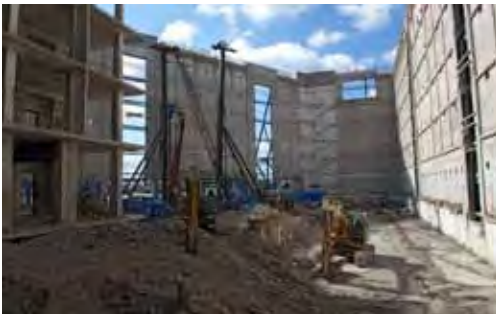
Abb. 43: Vollständige Entkernung und Abbrucharbeiten im Inneren des Kaispeichers A Ende 2007
