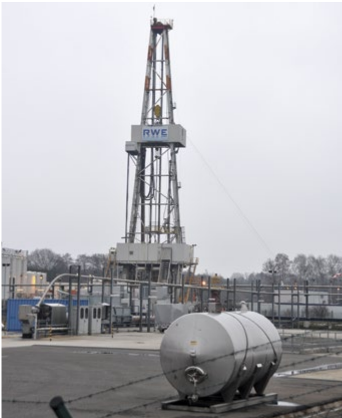
So sieht ein Bohrturm fürs Fracking aus: Dieser ist etwa 56 m hoch und steht auf dem Betriebsplatz Völkersen. Der Betriebsplatz hat sechs Bohrlöcher und ist ca. 350 × 400 Meter groß. Foto: C. Schomann.
