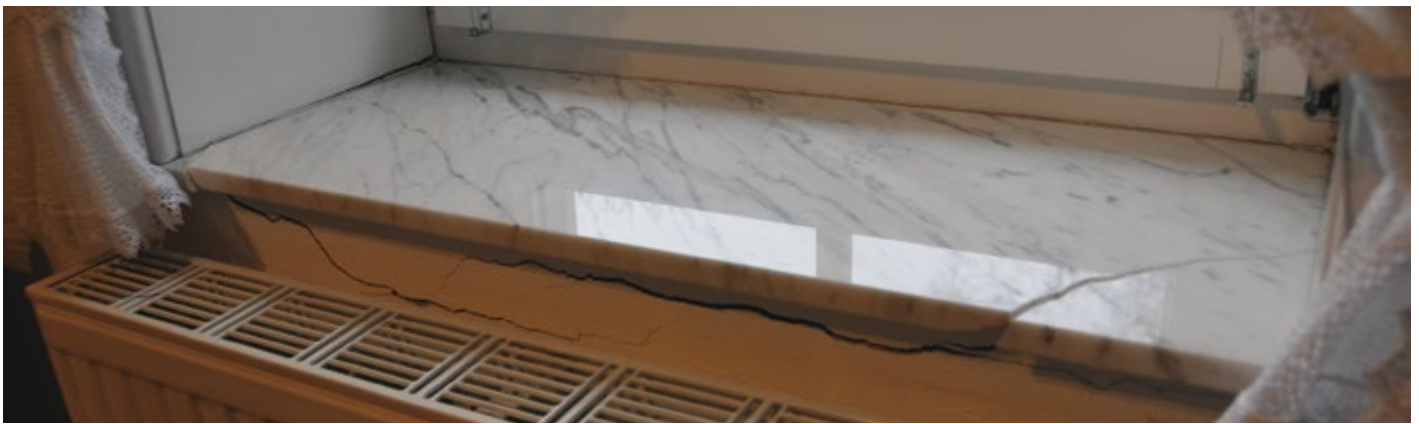
Diese Fensterbank ist bei einem Erdbeben am 22. November 2012 in Völkersen buchstäblich zerrissen. Das Haus steht rund einen Kilometer vom Betriebsplatz Völkersen entfernt. Foto: C. Schomann.
