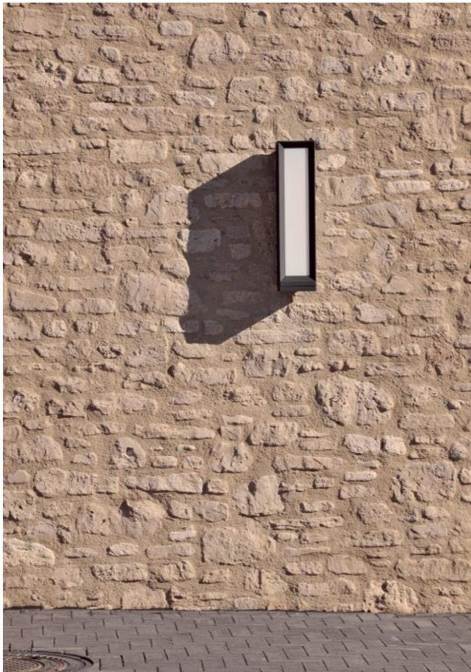
*Dem facettenreichen Erscheinungsbild des Bruchsteinmauerwerks liegt eine aufwendige Be- und Verarbeitung zugrunde. Die Travertin-Elemente wurden zunächst polygonal gespalten, getrommelt und in verschiedenen Größen verlegt. Anschließend erfolgte eine maschinelle Spritzverfugung und Sandstrahlung. (Foto: TRACO)*
