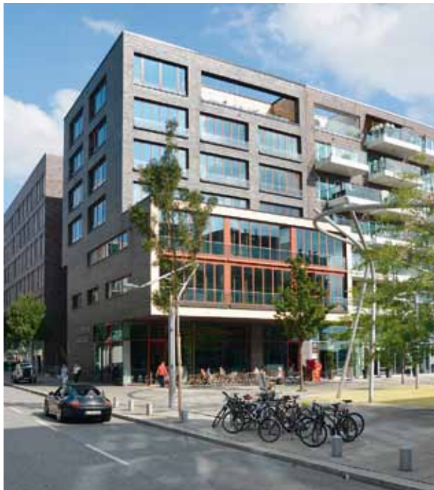
Dalmann-Carrée: Die Architektengemeinschaft aus MRLV, Bernhard Winking und Spengler Wiescholek einigte sich darauf, für das Gebäude einen einzigen Stein zu verwenden
