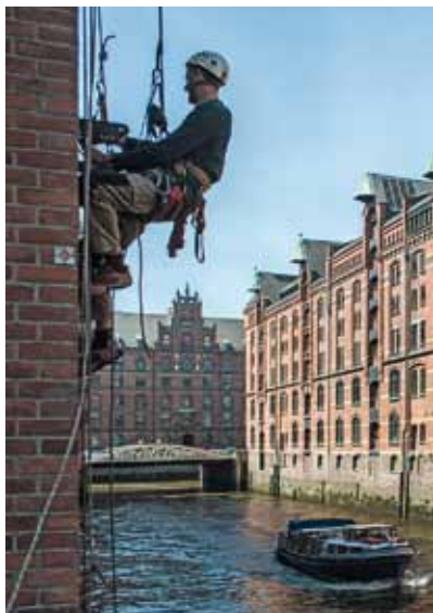
Fassadenkletterer: An wenigen ausgewählten Stellen werden die Leuchten montiert
