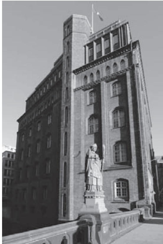
Das Haus der Patrio- tischen Gesellschaft an der Trostbrücke
