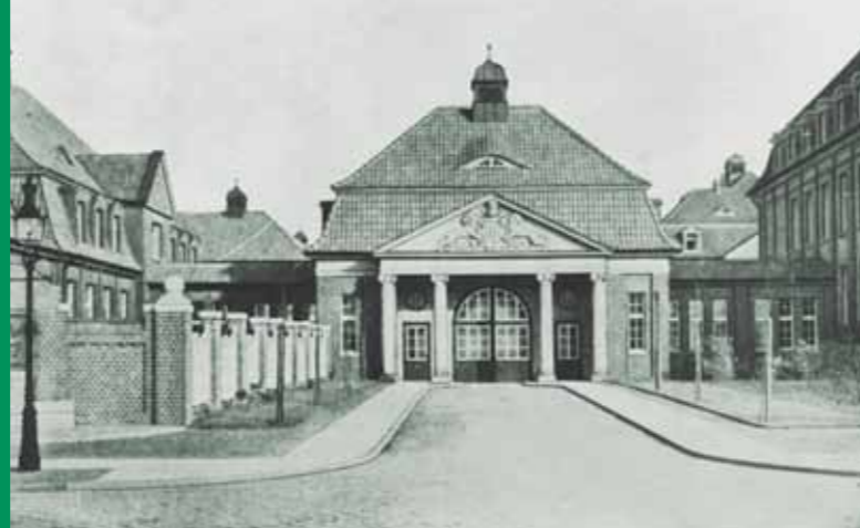
Torgebäude (Krankenaufnahme), um 1914
