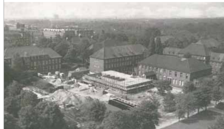
Neubau zur Erweiterung von Operationshaus, Urologie und Röntgen 1963
