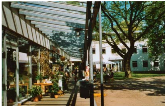
Service-Zentrum an der Hauptzufahrt
