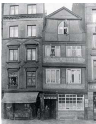
Kistenfabrik am Kafen, 1905: Das Gebäude wurde im Zweiten Weltkrieg durch Bomben zerstört.
