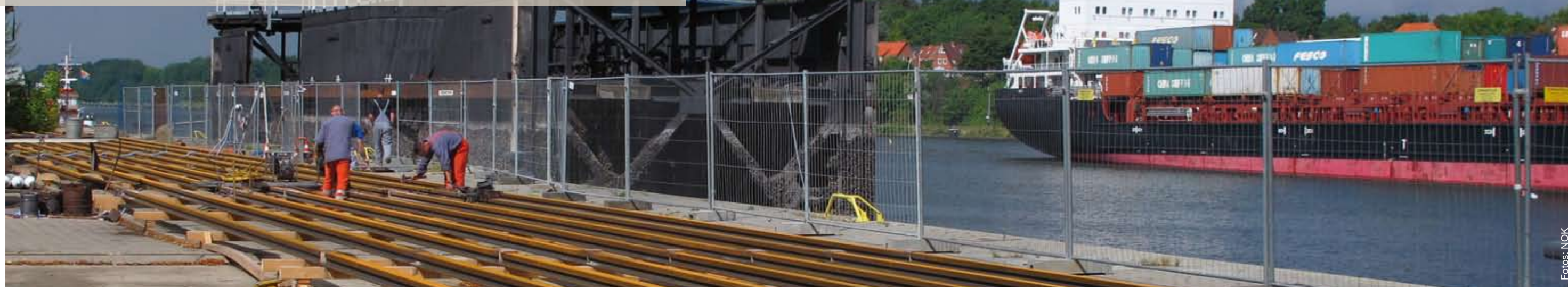
Noch liegen sie an Land: Die Schienen für die Schleusentore auf dem Kanalgrund wurden ausgetauscht
