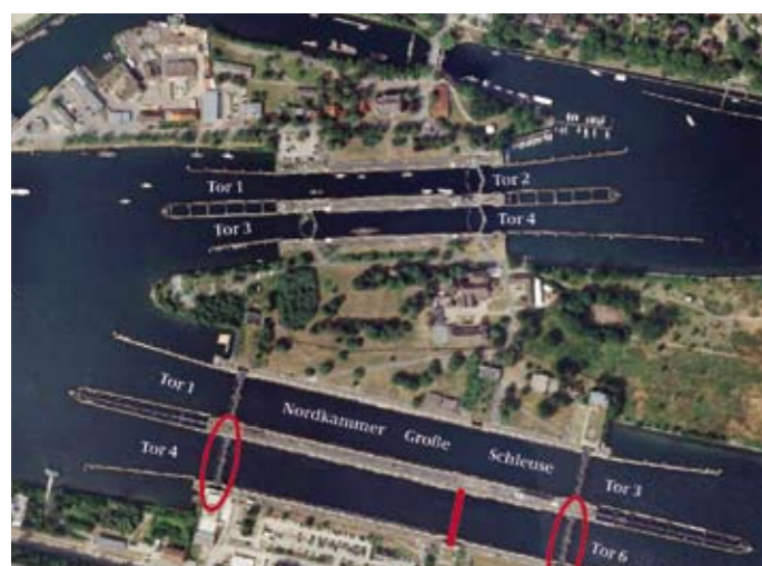
Schleuse Kiel-Holtenau: Zuletzt wurde die südliche Kammer saniert
