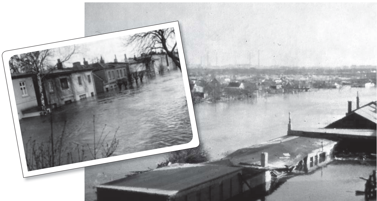
Abb. (von links): Hamburg-Wilhelmsburg nach der großen Flut. Der dicht besiedelte Stadtteil ist von der Außenwelt abgeschnitten, da alle Straßen unter Wasser stehen und somit alle Verkehrswege unterbrochen sind. Fotos: Gerhard Pietsch
