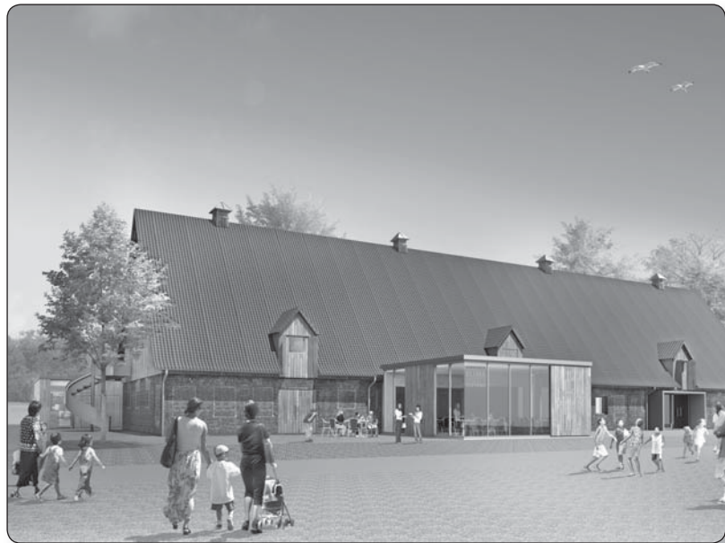
Abb.: Nach Sanierung und Ausbau beherbergt das Stallgebäude die neuen Angebote im Umweltzentrum Karlshöhe.
