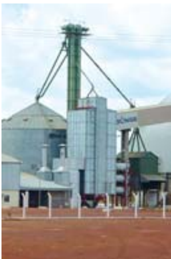
Verarbeitungsanlage der Firma Bunge
