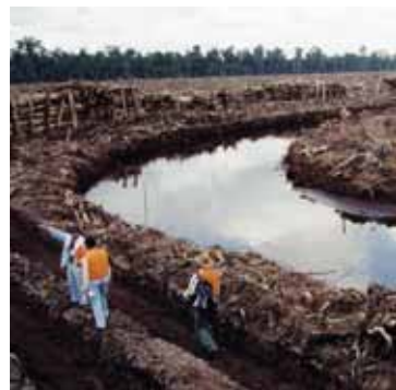
Das Kanalnetz entwässert den ökologisch wertvollen Torfwald
